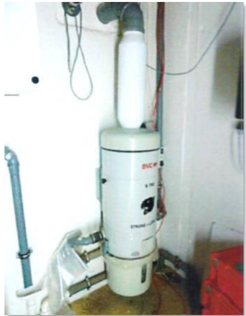
Zentrale Staubsauganlage
